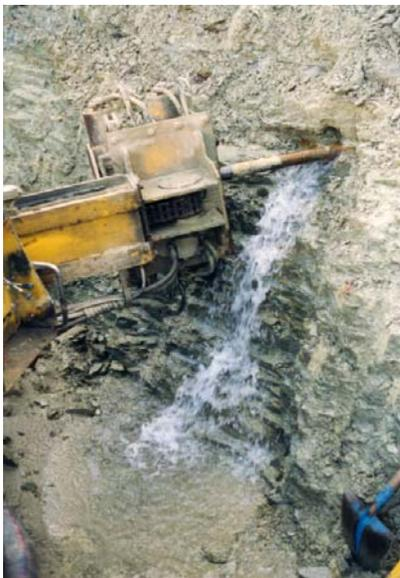
Forage d'un des trois drains de captage
